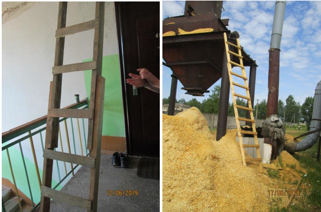
Сращивание деревянных приставных лестниц выполнено гвоздями
